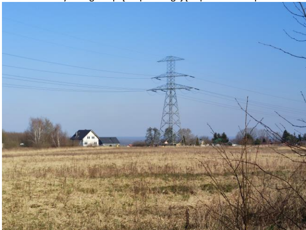
Fot.12. Linia wysokiego napięcia przebiegająca przez obszar planu.
